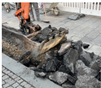
*Die alte Unterlage (Asphalt) wird abgetragen. Die neue Unterlage besteht aus wasserdurchlässigem Drainage-Beton.*
