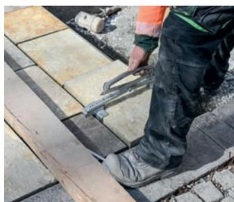
*Färbergasse: Einrichten der schweren Stainzerplatten mit speziellen Greifzangen.*
