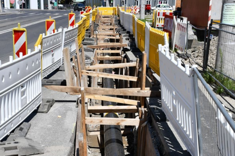
Fernwärmeleitungsbau in der Herrgottwiesgasse.
