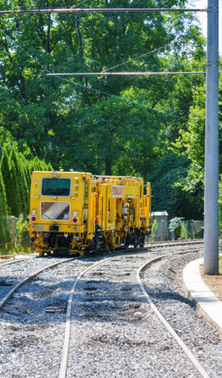
*Mit einer Gleisstopfmaschine wurden im Juli die Schienen auf der Linie 1 in die richtige Lage gebracht und der Schotter verdichtet.*
