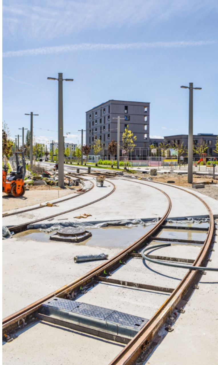
Die Kreuzung Straßenbahnlinie/ Wetzelsdorfer Straße in Richtung Endstation Reininghaus.
