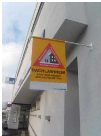
(Bild: Dachlawinenfahne montiert auf Häuserfront)
